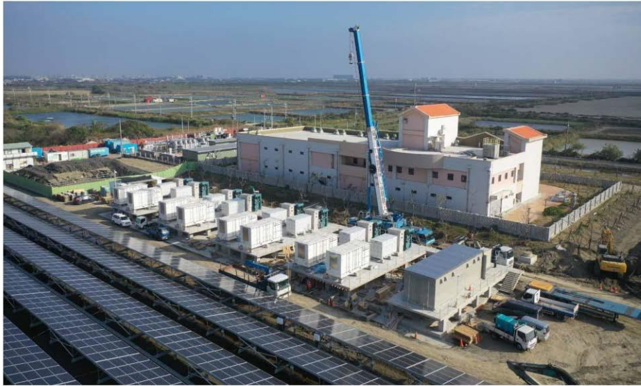
圖 1、台南鹽田光電站儲能系統施工照片
