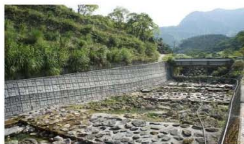
河道梳子壩及邊坡崩塌地穩定
